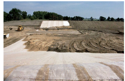
Lagenweise eingebautes Secugrid® Geogitter
