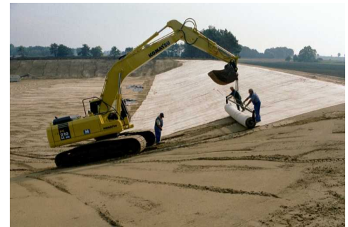
Verlegung der Tondichtungsbahn Bentofix®
