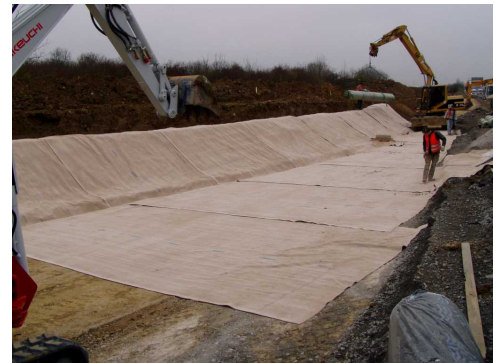
Einbau der Bentofix® GTD
