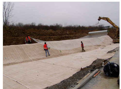
Einbau des Secugrid® Geogitters
