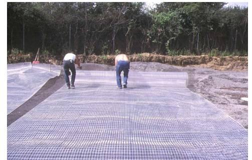
Secugrid® Verlegung
